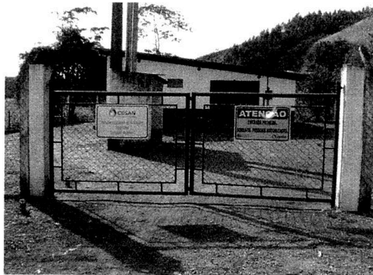
Figura 14: Estação Elevatória de Água Bruta.
